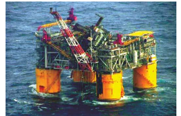
Plataforma avariada no Golfo do México após a passagem do Katrina (CCSP, 2007)
